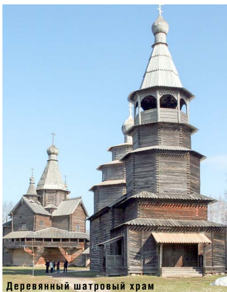
Деревянный шатровый храм
